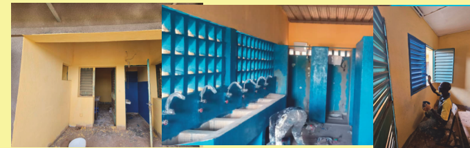
Renovierungsarbeiten im Mädchenwohnheim "Torima"
